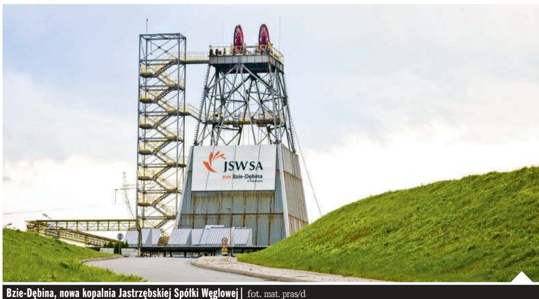
Bzie-Dębina, nowa kopalnia Jastrzębskiej Spółki Węglowej | fot. mat. pras/d
