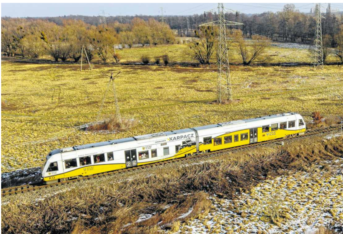
• Linia kolejowa nr 326 na odcinku od Wrocławia Zakrzowa do Trzebnicy przed zamknięciem jej na czas remontu
