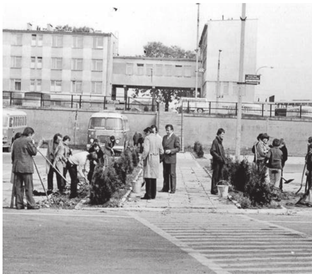
(ŁD) Biurowiec na chrzanowskiej zajezdni PKS w latach 80. XX w.
