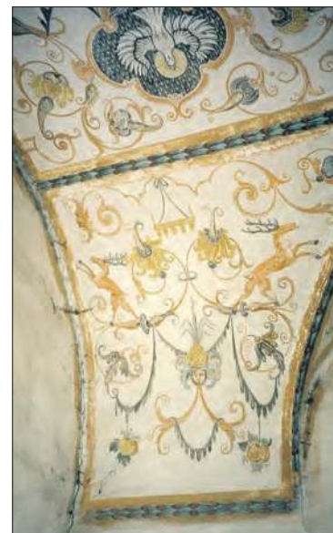
Sufit w dawnej kaplicy św. Huberta
