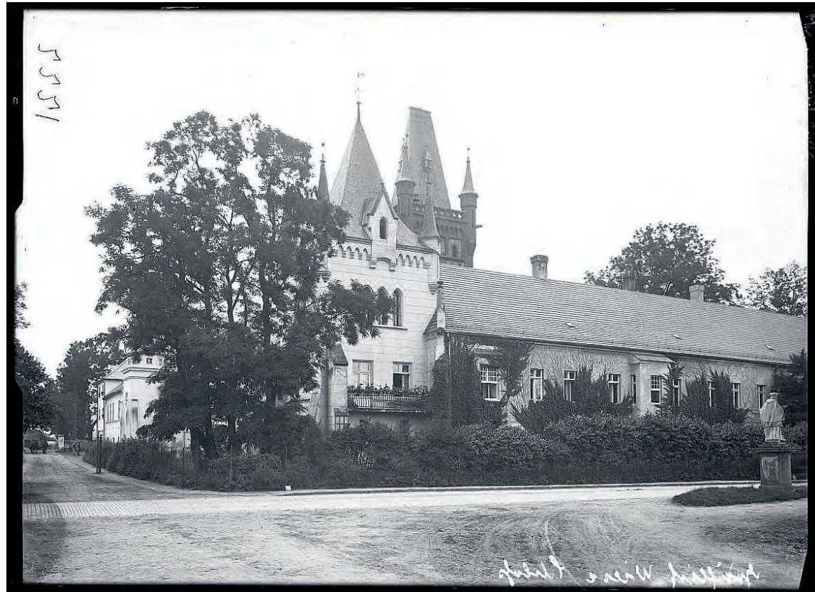
Widok na zamek od strony ul. Zamkowej. Budowla była otoczona zielenią.
