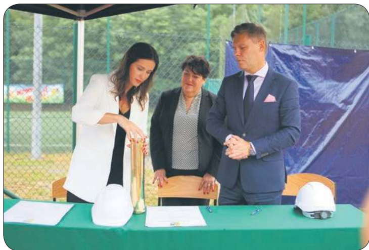
Akt erekcyjny pod budowę nowej części szkoły podpisali m.in.: wójt Gminy Słupno - Marcin Zawadka, Joanna Wereszczyńska - naczelnik Wydziału Inwestycji, Infrastruktury i Rozwoju UG Słupno, Agnieszka Domińska - dyrektor SP w Liszynie
