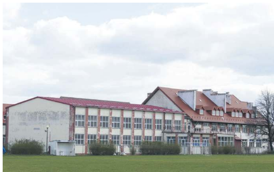
„Termomodernizacja budynków szkolnych w Przewornie”, to zadanie polegające na poprawie efektywności energetycznej obiektu
