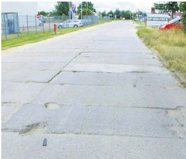
Ulicę Energetyków w obrębie Pęcz w gminie Strzelin czeka gruntowny remont
