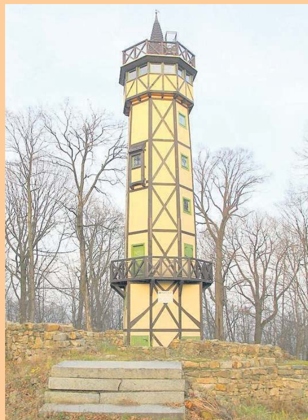
Obecnie trwają prace konserwacyjne wewnątrz wieży widokowej na Gromniku. Po ich zakończeniu zostanie otwarta, o ile pozwoli na to sytuacja epidemiologiczna
