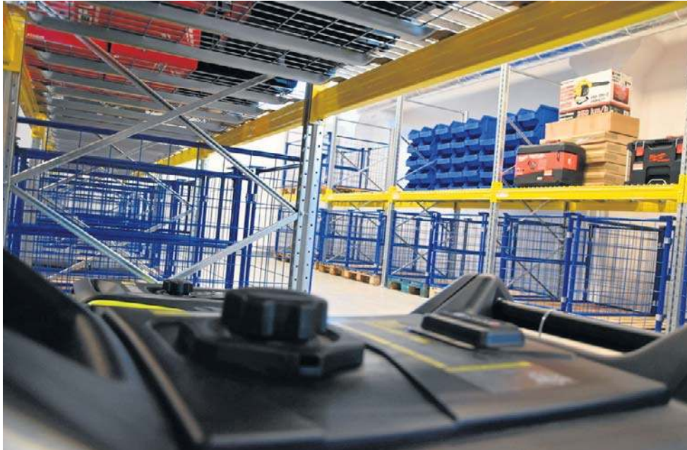
Pierwsze sprzęty zostały już kupione. Znalazły miejsce w wyremontowanych pomieszczeniach magazynu
