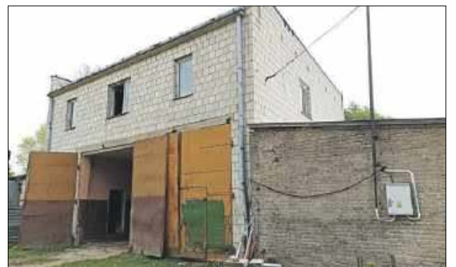
Budynek po dawnym SKR przed modernizacją
