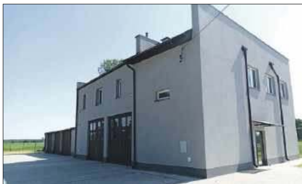
Budynek po dawnym SKR został gruntownie zmodernizowany oraz kompleksowo wyposażony. W nowoczesnym obiekcie rozpoczęła swoją działalność Spółdzielnia Socjalna pn. „Wspólna Chata”
