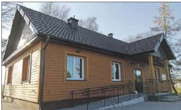
W Żukach świetlica również została poddana termomodernizacji. Wymieniono też pokrycie dachowe i stolarkę okienną-drzwiową. W ramach projektu zakupiono również jej wyposażenie
