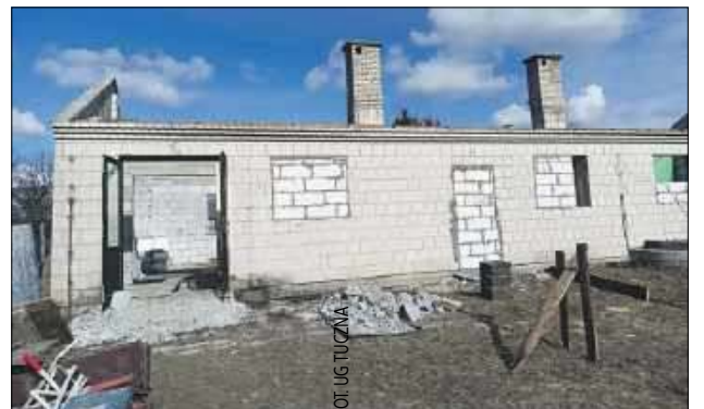
Świetlica w Bokince Królewskiej w trakcie modernizacji
