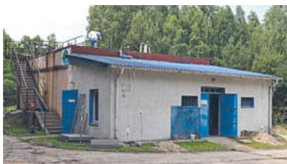
– Tak wyglądała oczyszczalnia ścieków w Krzywdzie przed modernizacją.
