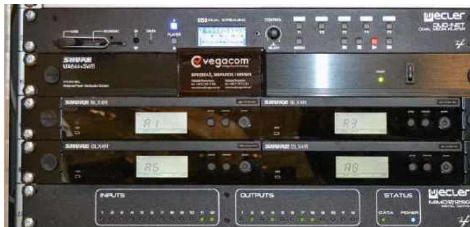
Źródłem sygnałów audio mogą być m.in. sygnały z mikrofonów bezprzewodowych Shure BLX4R lub media player DUO-NET Eclera.
