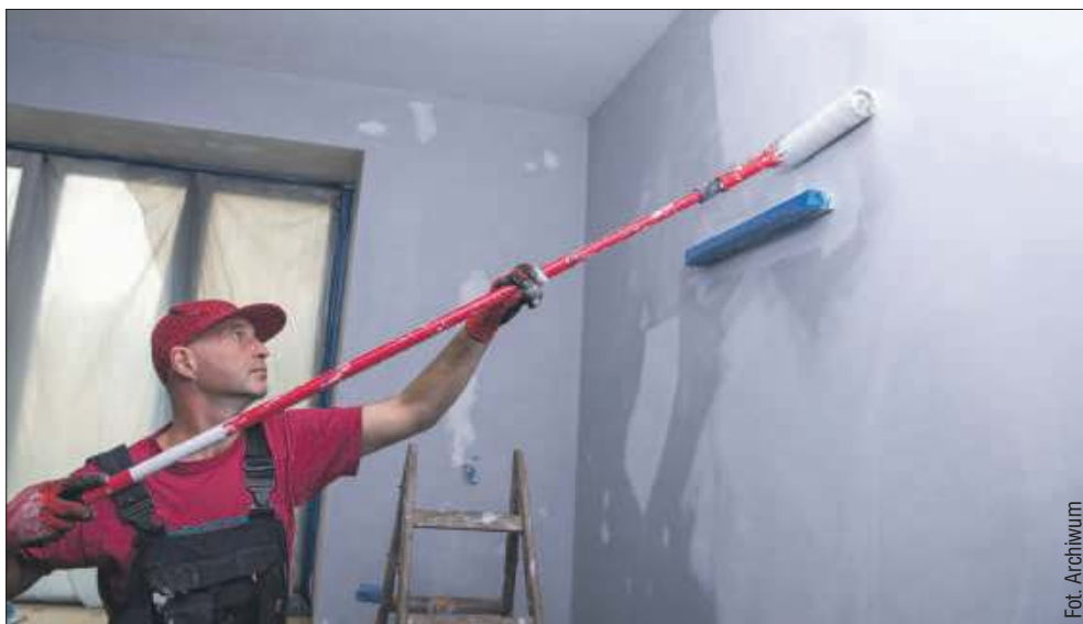
Odmalowywanie ścian, doposażanie sal - to zadania realizowane w czasie przerwy wakacyjnej w szkołach na terenie powiatu.
