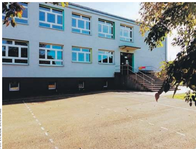
Rozbudowa SP nr 6 w Kościelcu miała się rozpocząć w tym roku
