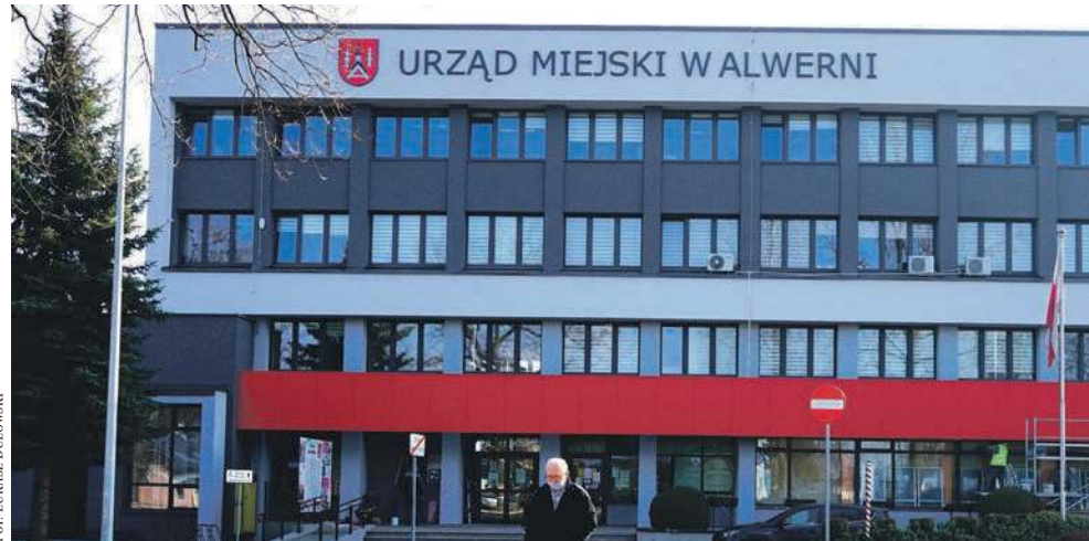
Wyremontowany w tym roku Urząd Miejski w Alwerni
