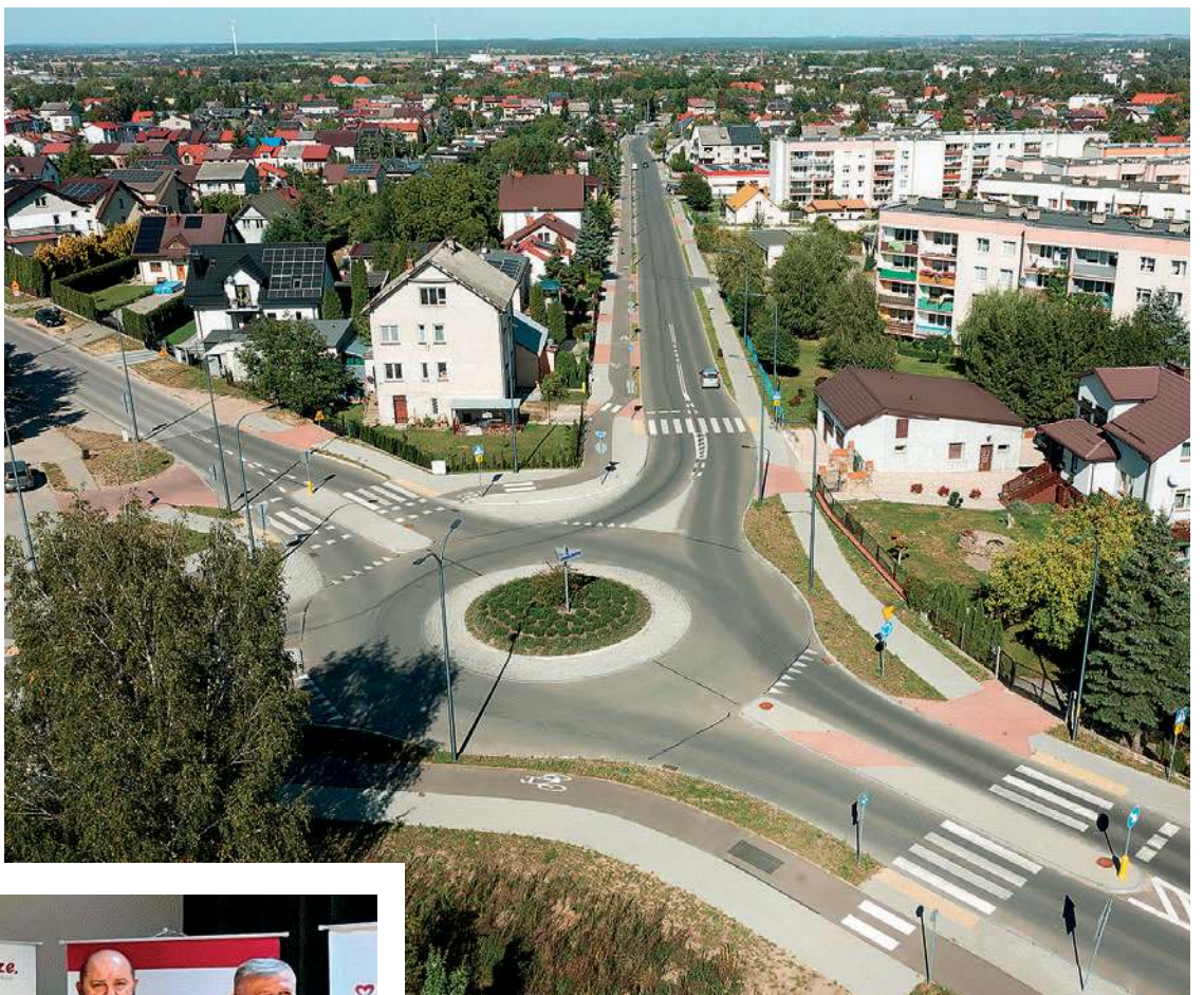
Sejmik pomógł w modernizacji ulic Granicznej i Widnej w Ciechanowie
