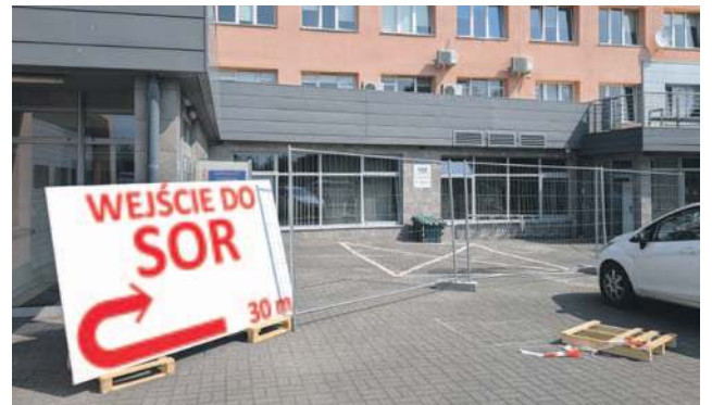
Nie da się ukryć, że trwa przebudowa
