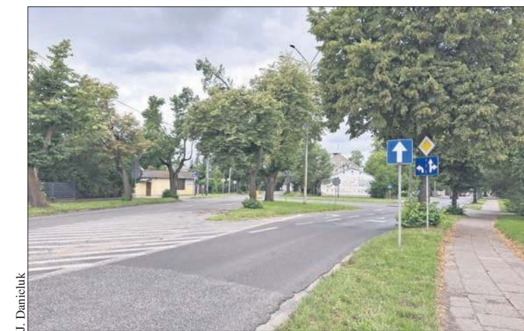
Czas na remont ulicy Wyszogrodzkiej
