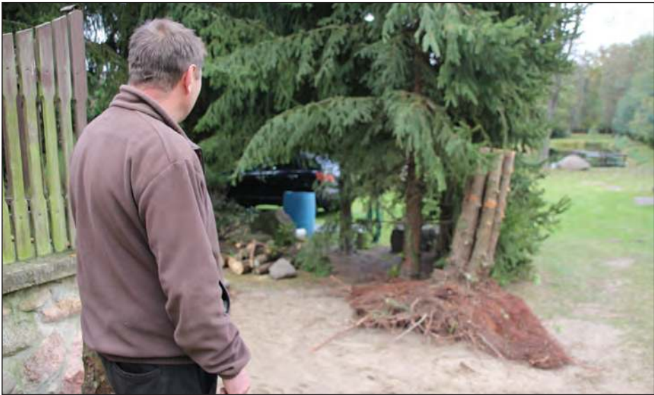
■ Pan Mariusz wciąż z niedowierzaniem spogląda na miejsce, w którym robotnicy kopiąc rów pod przewód elektryczny natrafili na ludzkie kości. Były tuż przy werandzie jego domu
