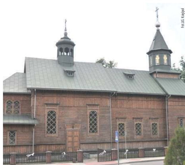
Kościół pw. Św. App. Piotra i Pawła w Majdanie Starym wkrótce przejdzie remont. Do wydania jest blisko pół miliona złotych
