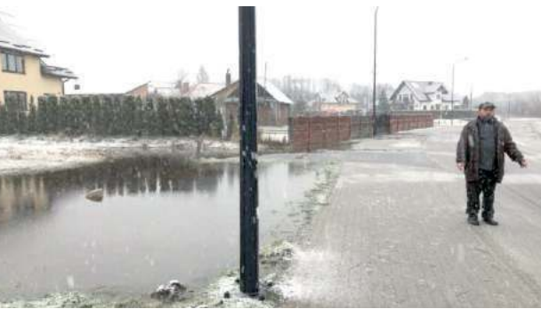
Tak było zimą, a od tamtego czasu nic się nie zmieniło. Pan Edward mieszkający przy ulicy Nowakowskiego 80 od lat walczy z wodą przelewającą się przez ulicę i zalewającą mu posesję. Urzędnicy obiecywali rozwiązanie problemu, ale, póki co, nic się nie zmieniło
