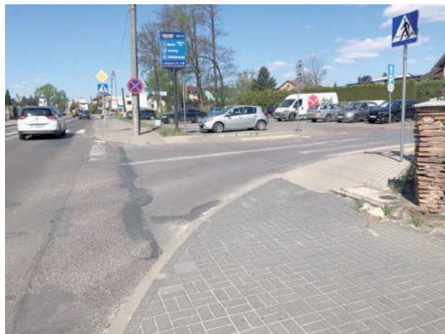
Rada Powiatu zdecydowała, że inwestycja polegająca na budowie chodnika i ścieżki rowerowej na ulicy Bagiennej powinna zostać zrealizowana
