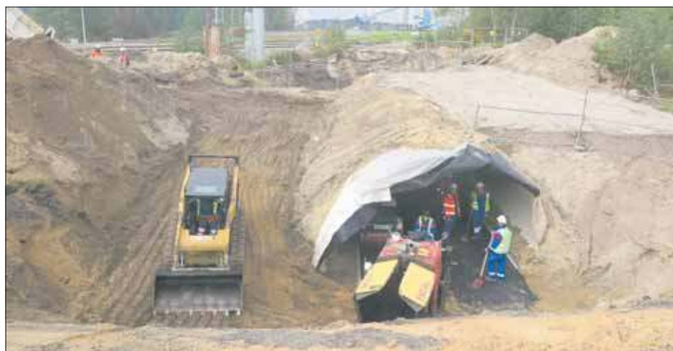
Wydrążono tunel, który będzie biec pod ulicą
