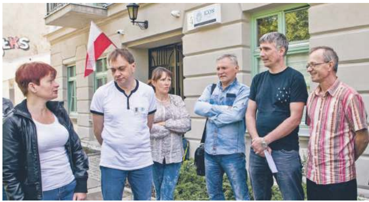
Mieszkańcy kamienicy przy ul. Wrześnińskiej w Łodzi złożyli doniesienie do prokuratury na właściciela budynku | fot. Jan Środa/Gazeta Polska
