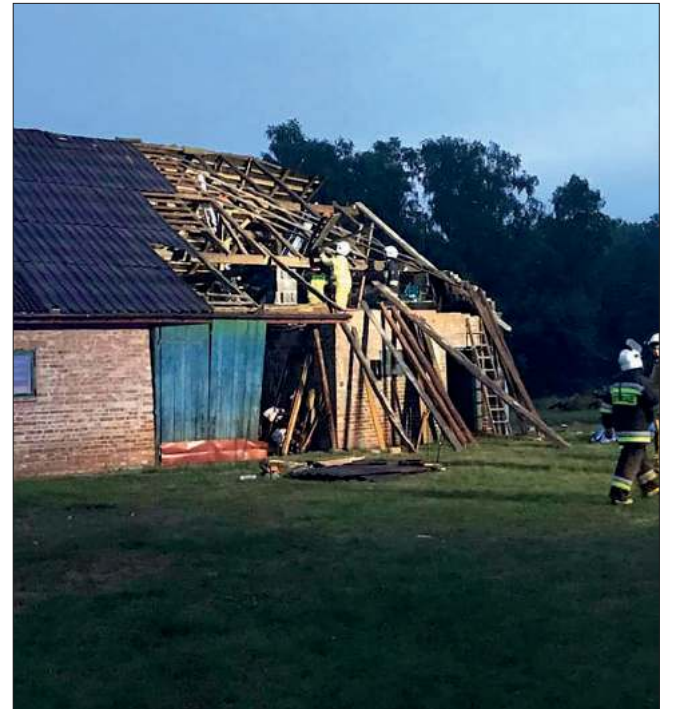
Zerwany dach na budynku gospodarczym w miejscowości Dulcza Wielka.
