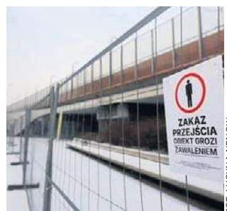
Estakada w Chorzowie nadal jest zamknięta
