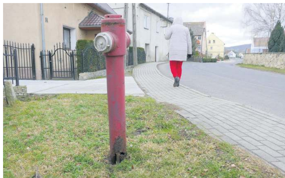
Urządzenie przy ul. Pocztovej w Przewornie nie nadaje się do eksploatacji
