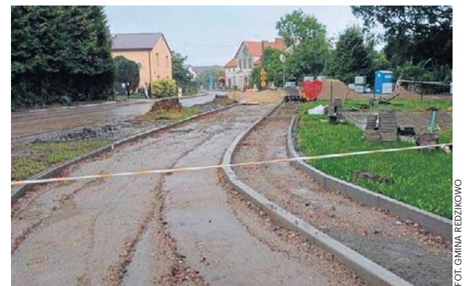
Budowa nowych ścieżek rowerowych w gminie Redzikowo
