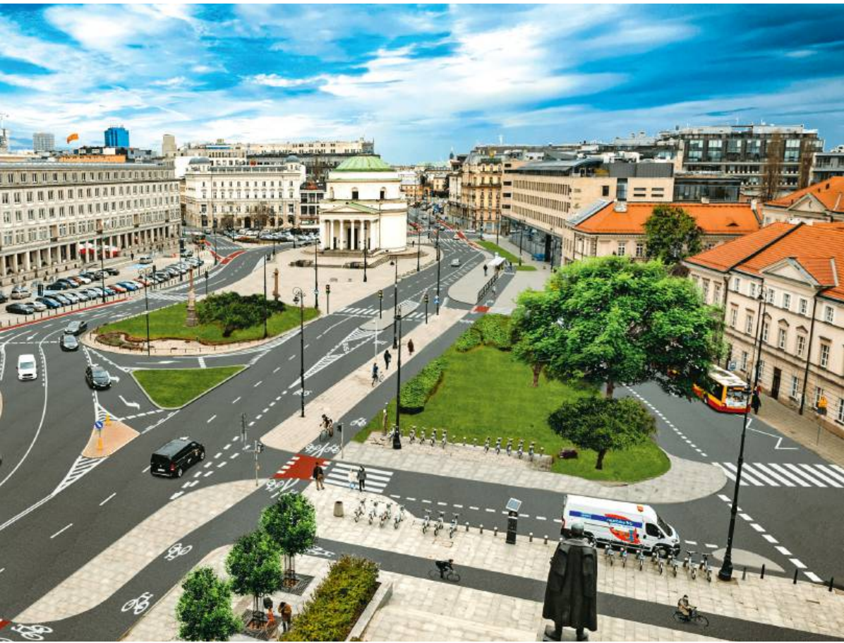
Plac został przebudowany bez sensu – uważają mieszkańcy Warszawy | fot. ZDM/d
