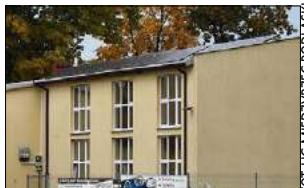
Na budynku SP w Rzeczycy w ramach projektu zamontowano panele fotowoltaiczne
