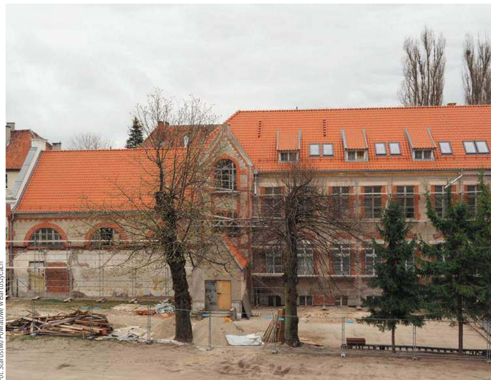
Trwają prace remontowe budynku przy ulicy Lipowej w Bartoszcach
