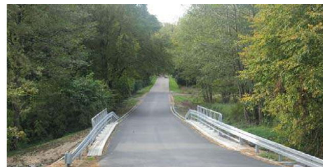
Wzmocnienie nawierzchni drogi powiatowej Nr 1232N Wirwajdy-Smykowo-Szyldak-Ōlsztynek (Ostrowin)
