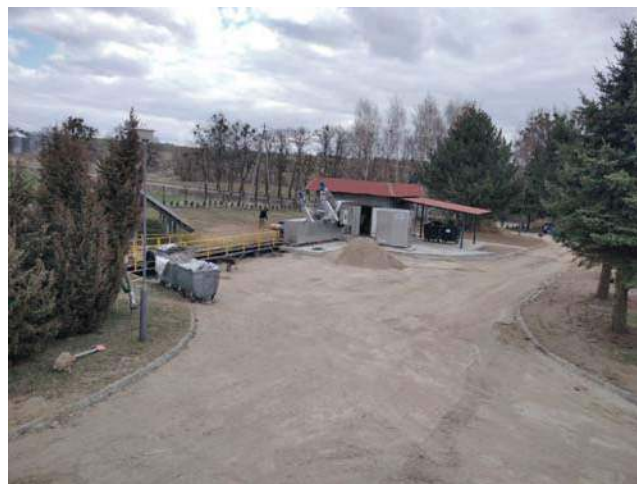
Przebudowa i rozbudowa oczyszczalni ścieków w Reszlu.
