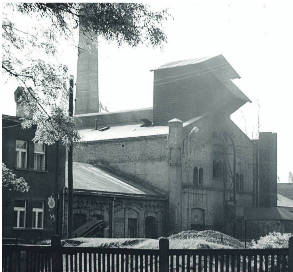
Gazownia „od tyłu”, widać hałdę węgla i wózek, który po pionowych szynach wjeżdżał do pieca
