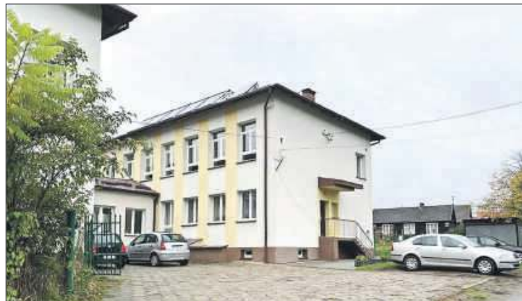
Prace przy szkole zostaną wykonane, jeśli uda się zdobyć dofinansowanie.
