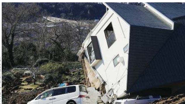
Zniszczony dom po trzęsieniu ziemi w Kanazawie (Japonia)
