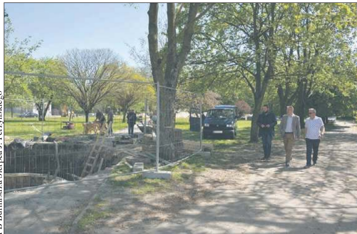
Obecnie odbywają się remonty terenu przy Placu Chopina
