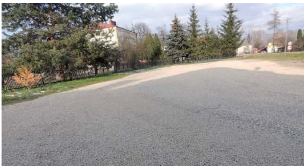
Na parking kościelny w Wilkowie trafiło w listopadzie 15 ton tłucznia, za który zapłacił Zarząd Dróg Powiatowych w Opolu Lubelskim. Jego wartość wynosi około 850 zł
