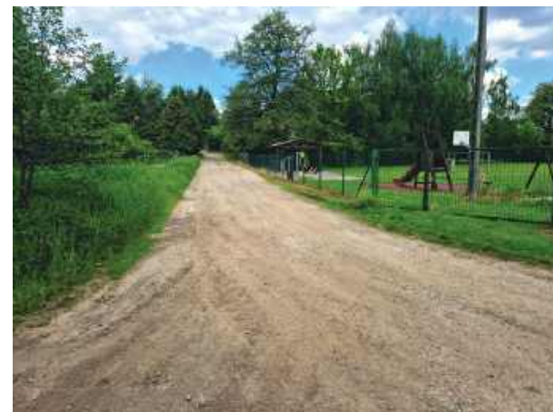
Gmina Kondratowice planuje remont drogi w Strachowie. Inwestycję dofinansuje Nadleśnictwo Henryków. Fot. UG Kondratowice
