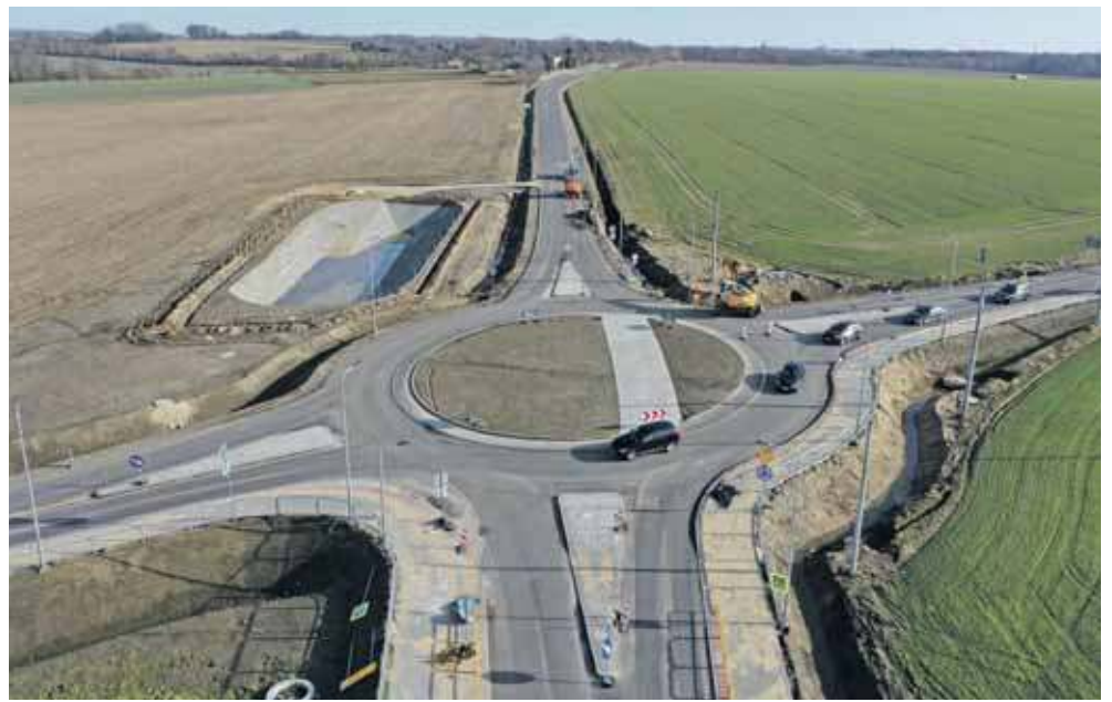
Przedłużają się prace przy przebudowie drogi krajowej
