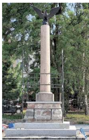
Prace są już zaawansowane, wszystko powinno być gotowe jeszcze w wakacje
