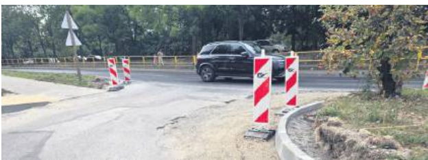
Prace potrwać do grudnia. Fot. UM Zamość
