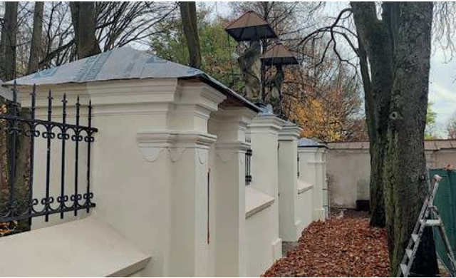
Remont fragmentu muru otaczającego klasztor w Alwerni
