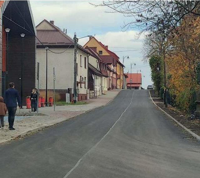
Wyremontowana ul. Korycińskiego w Alwerni
