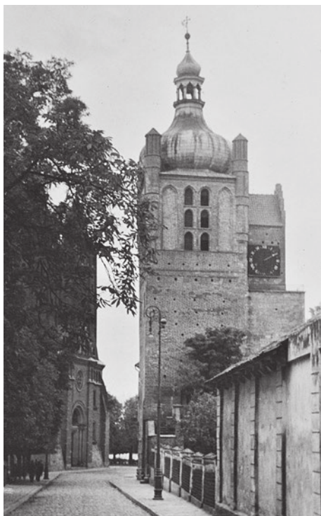
Dzwonnica katedralna w Płocku wraz z przylegającą do niej wieżą zegarową
