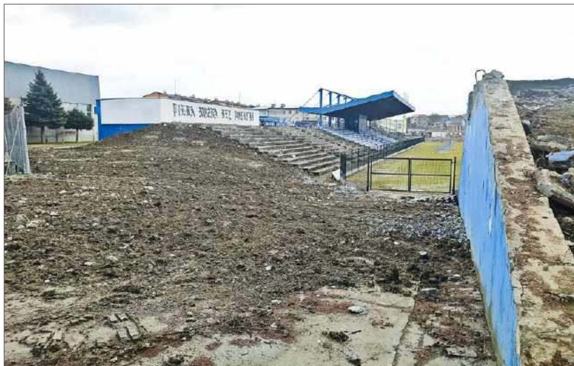
Praca na stadionie miejskim wre. Wokół murawy wybudowane zostało nowe ogrodzenie.
