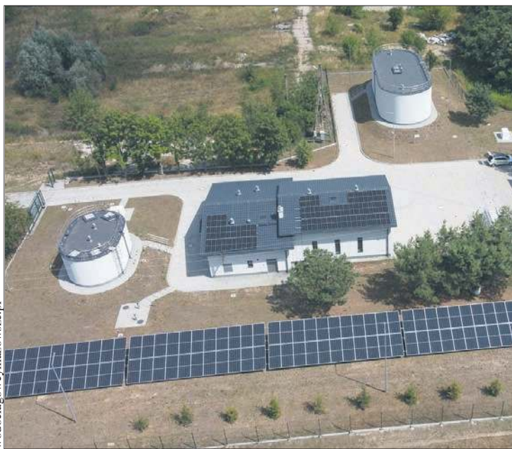
Panele fotowoltaiczne przy ujęciu wody Grabówka
