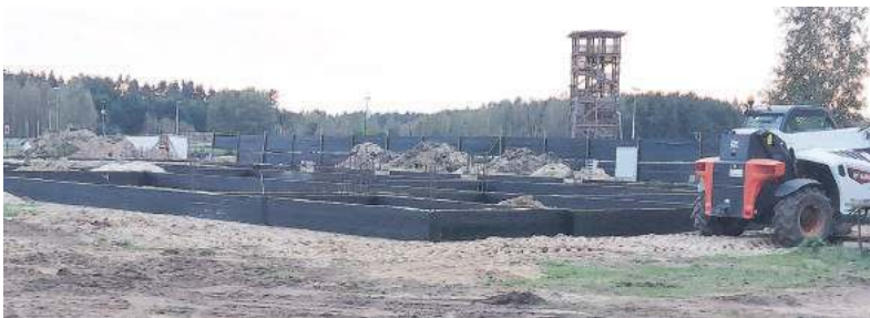
Budowa centrum multimedialnego przy Zalewie Podwolina stała się faktem
