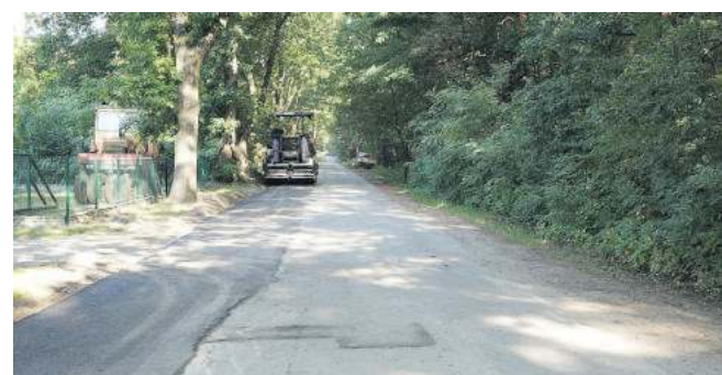
Remont pierwszego odcinka ulicy Hubala ma potrwać do końca października. Po zakończeniu prac szerokość drogi z trzech metrów zwiększy się to pięciu
