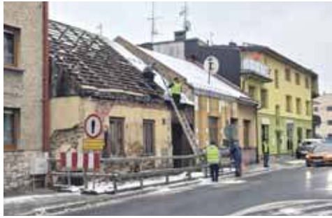
Rozbiórka budynku przy ul. Szaflarskiej.
