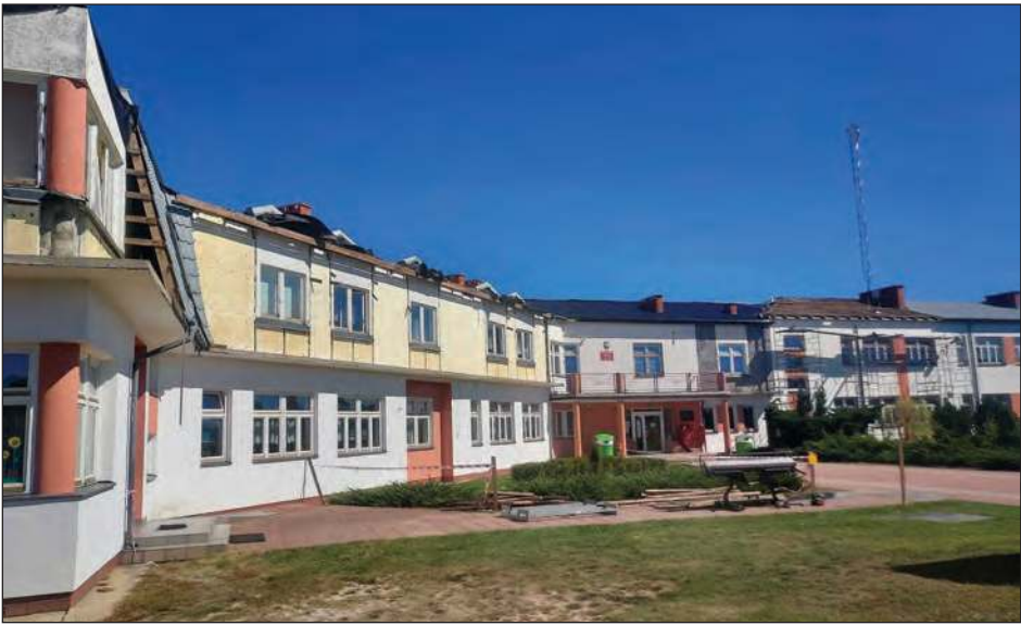
➤ W ramach tegorocznego etapu prac zostanie zmodernizowane pokrycie dachowe na całym budynku wraz ze wszystkimi obróbkami blacharskimi
