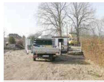
Prace na oczyszczalni w Stepnicy idą pełną parą
