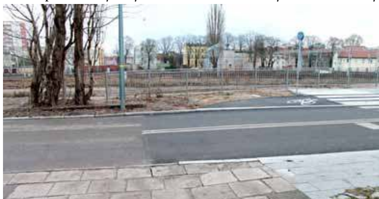
Jak widać na zdjęciu prawa strona drogi na ul. Towarowej od strony ZCP jest wraz z chodnikiem wyremontowana, natomiast wiele do życzenia pozostawia lewa strona
