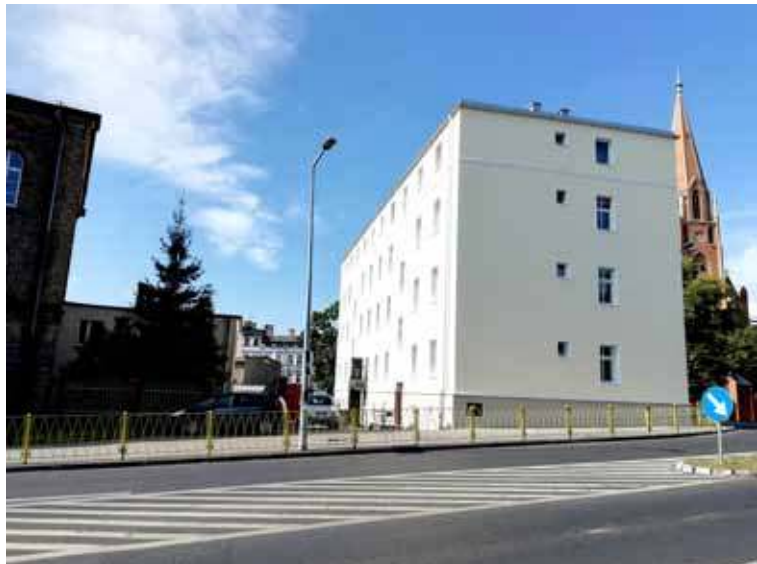
Budynek po termomodernizacji przy Placu Świętego Ducha 26
