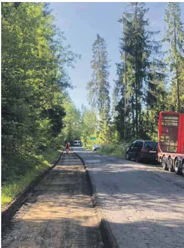
Droga w Dzianiszu doczekała kompleksowego remontu.
