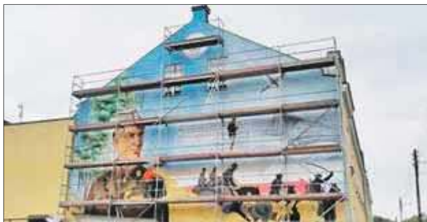
Trwają prace nad murem poświęconym generałowi Władysławowi Sikorskiemu
