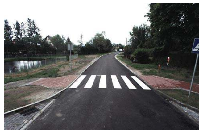
Pilon: wyremontowany odcinek drogi gminnej
