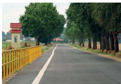
Droga Winnica – Błędostowo po przebudowie
