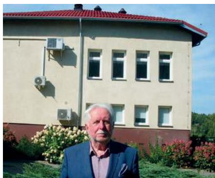
Dyrektor Włodzimierz Wojnarowski przed budynkiem, na którym wymieniono pokrycie dachowe
