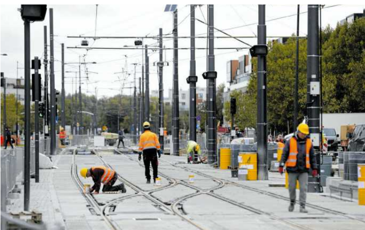
• Sobota, al. Rzeczypospolitej przy Branickiego. Trwają prace na budowie tramwaju do Wilanowa FOT. KUBA ATYS / AGENCJA WYBORCZA.PL
